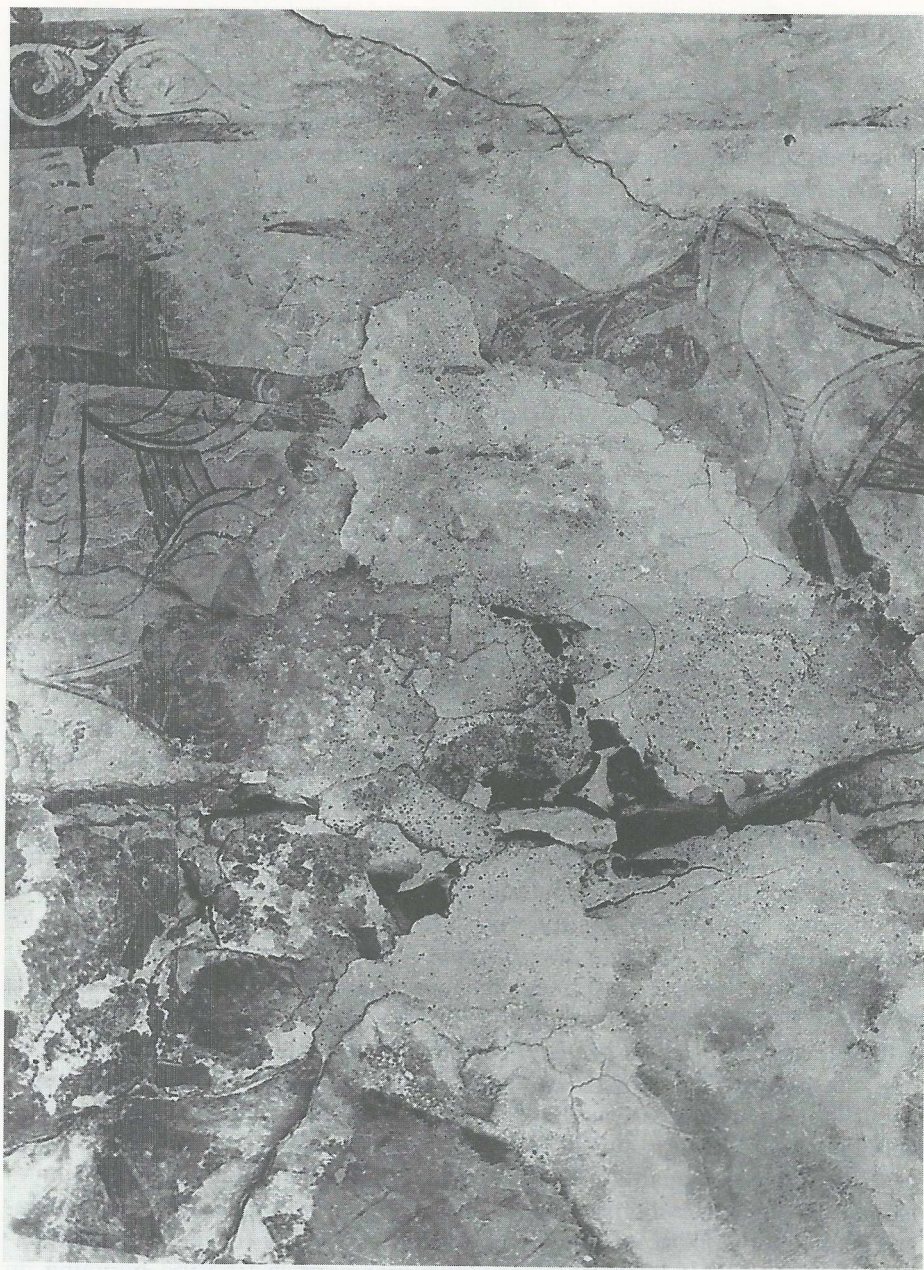
8. Décor de la travée du chœur. Voûte : deux figures d'anges.
